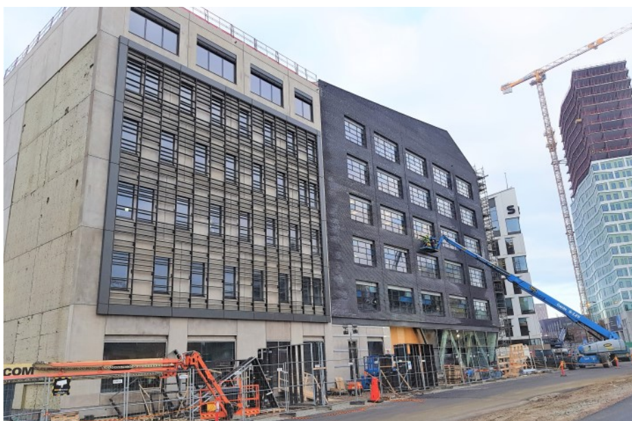
Montering av balkongmarkiser på Regissörsgatan i Malmö.
